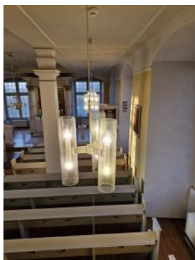
Diese Leuchten aus den 1980er Jahren werden ausgetauscht
