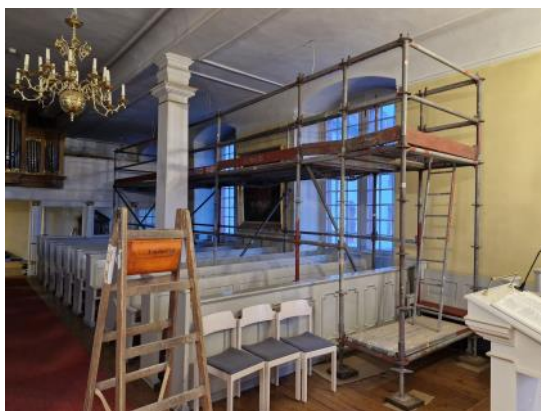
So sah die „Baustelle“ Mitte Februar aus. Für die Montagearbeiten wurde ein Gerüst behutsam zwischen den Bankreihen platziert. Der Gottesdienst am 15.2. wurde ins Gemeindehaus verlegt.
